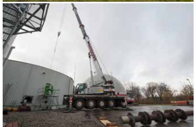
Wartungs- und Reparaturarbeiten in der Biomethananlage.
